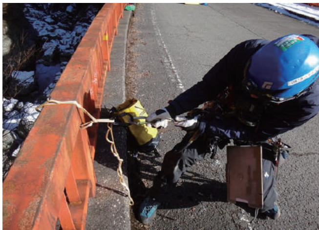
高欄の仮荷重テストの様子
