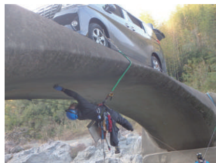
橋面に停めた車両をアンカーに使用
