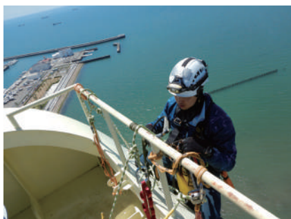
転落防止柵をアンカーに使用
