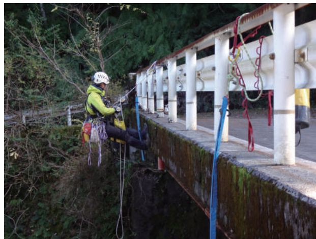
高欄にメインロープ支点を作成し下降…の様子
